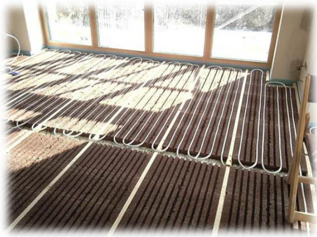
Abbildung 25: Einsatz von alten Dachziegeln als Baustoff für Fußbodenheizung [8]
