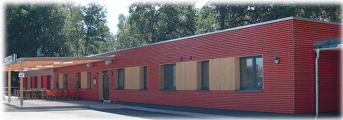
Abbildung 21: Einsatz von wiederverwendeten Plattenbauelementen [4]
