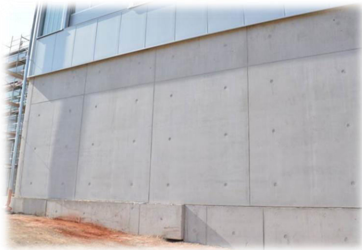
Abbildung 22: Einsatz von rezyklierten Gesteinskörnungen [5]
