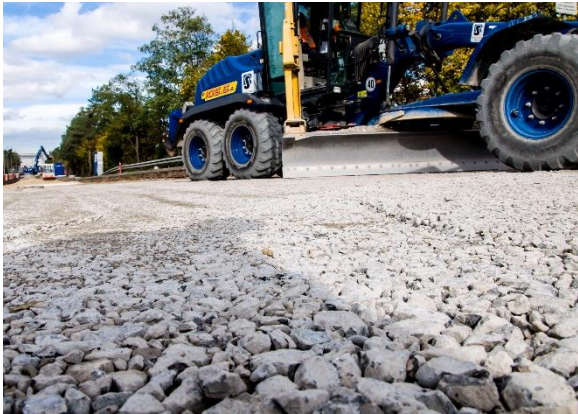
Abb. 9: RC Betongranulat als Frostschutzschicht [SÖR]
