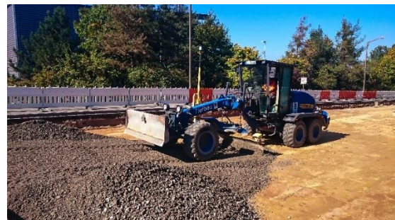
Abb. 20: Einbau Frostschutzschicht [SÖR]
