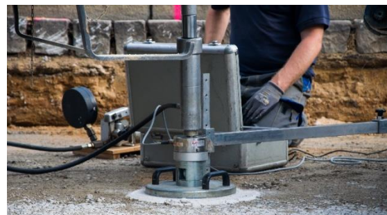
Abb. 21: Prüfung der Frostschutzschicht [SÖR]
