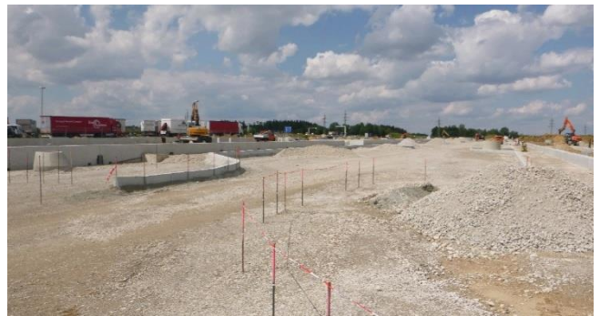
Abb. 16: Einbau RC Beton [Ettengruber]
